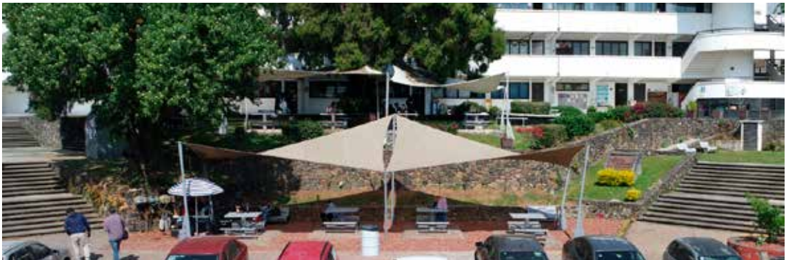
Se instalaron velarias en el espacio común frente al edificio 32, zona usualmente utilizada durante el descanso de los estudiantes.
