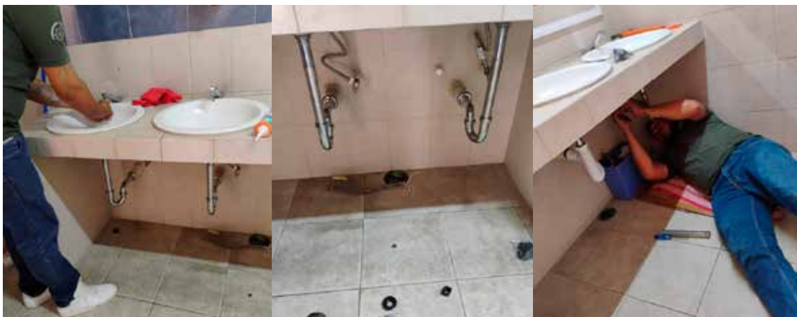
Reparación de baños en el edificio 32.
