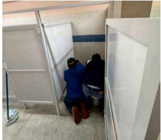
Se realizaron trabajos de plomería en los baños del edificio del 32.
