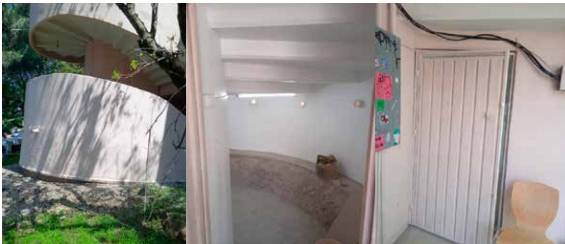
Se pintó la bodega de la parte interior y exterior del edificio 74.
