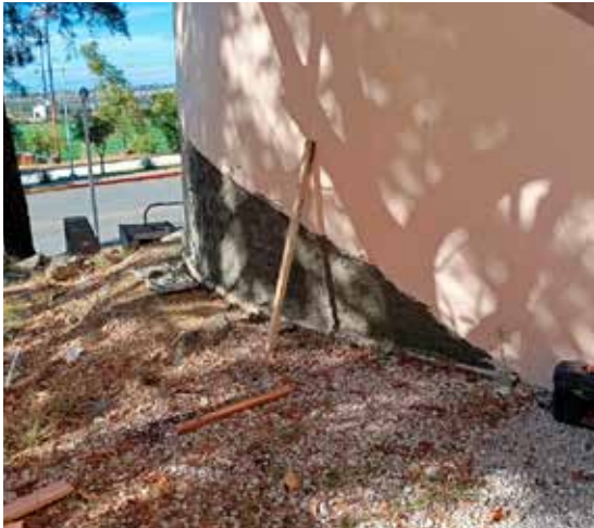
El Instituto inició los trabajos en la bodega de planta baja en el edificio 74
