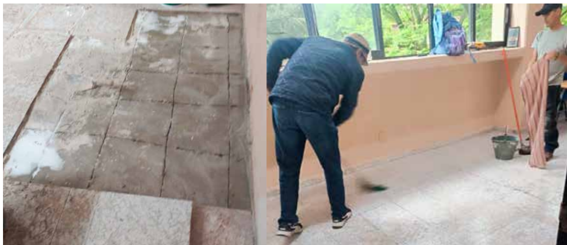
Se hicieron trabajos de reparación y mantenimiento al piso del salón 107 del edificio 32.
