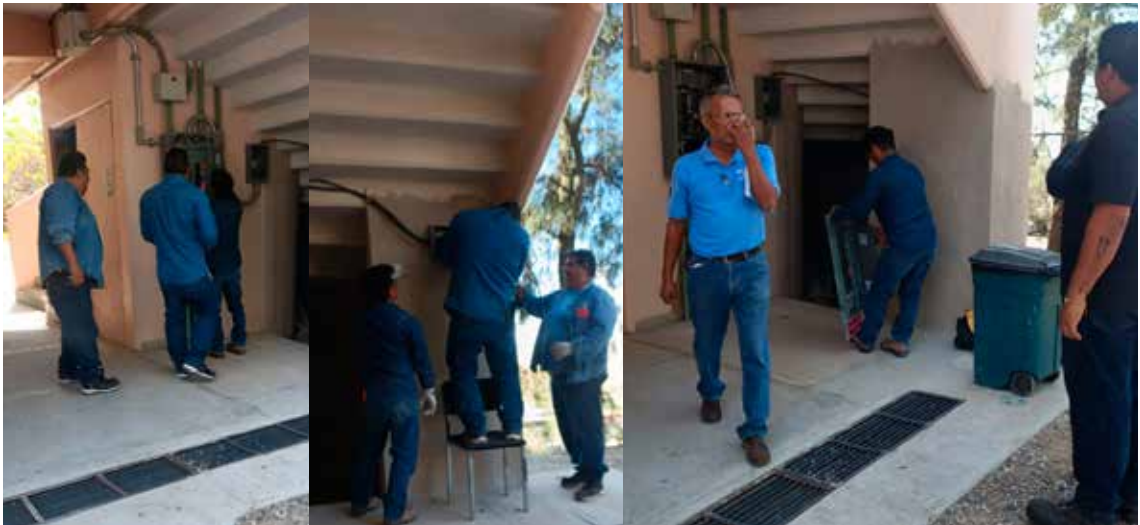
Se reubicó la bajada de luz que alimenta el edificio 74.
