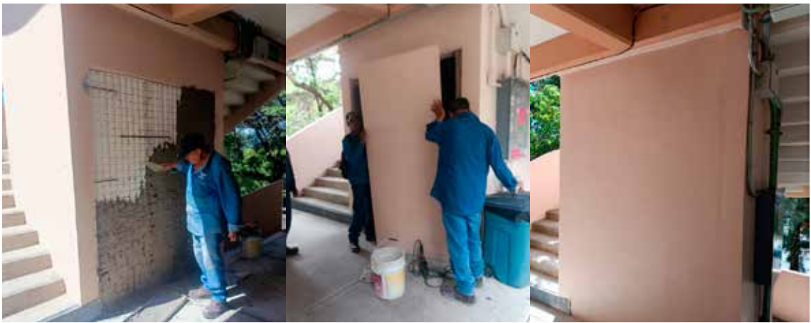
Se realizaron trabajos en los muros con material de albañilería en las puertas del cubo junto a las escaleras del edificio 74, dejando el acabado sellado en el primer y segundo nivel. En la planta baja se acondiciona el espacio para bodega de personal de intendencia.
