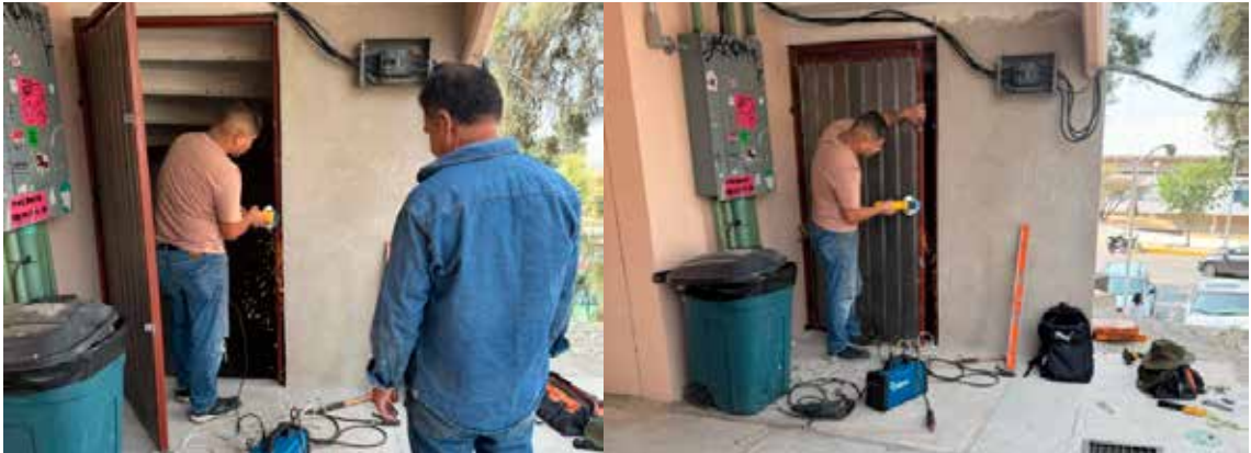
Se instaló la puerta de herrería para la bodega de la planta baja del edificio 74.
