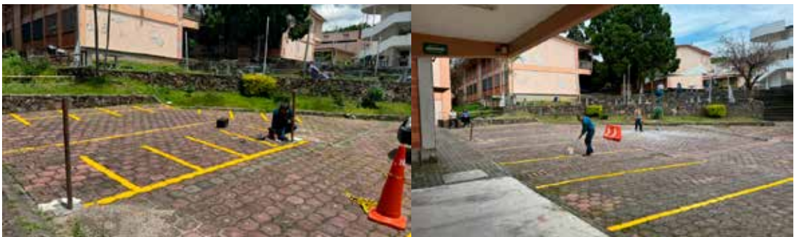
Se colocaron tubos para delimitar el estacionamiento de motos y autos en el edificio 32.
