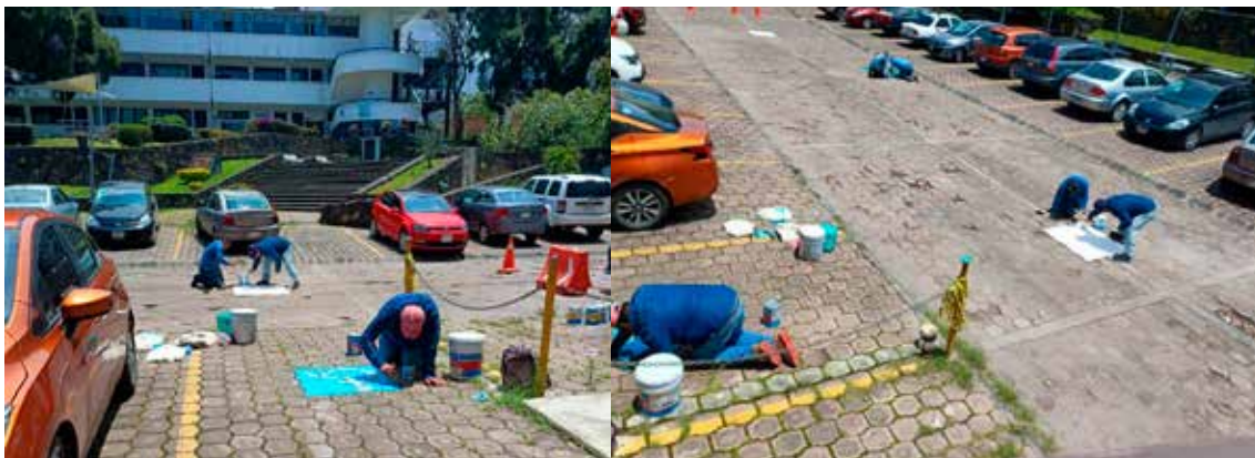
Se pintó la señalización en el estacionamiento del edificio 32
