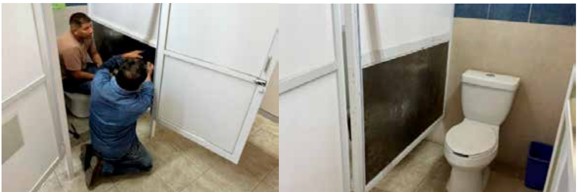
Se adaptaron mamparas de aluminio en baños de hombres del edificio 32.
