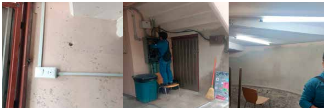
Se realizó la instalación eléctrica en la bodega de la planta baja del edificio 74.
