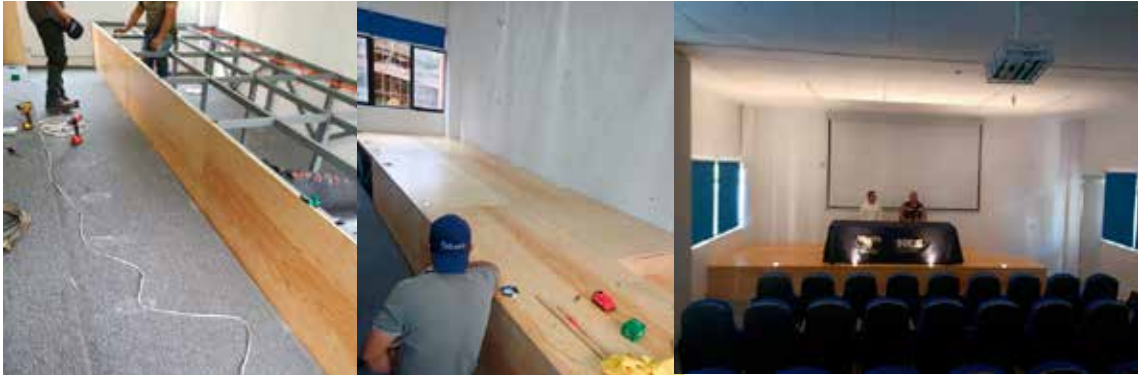
Se instaló el template en el auditorio del edificio 74
